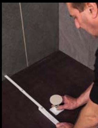
**7** Schalldämmfuß mittig unter der Wanne ausrichten.
