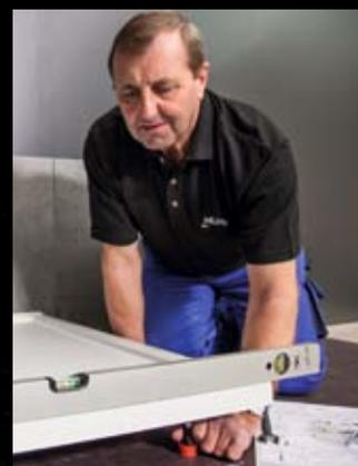
**8** Duschwanne in der Duschecke aufstellen, Ablaufgarnitur anschließen und Duschwanne waagrecht ausrichten.
