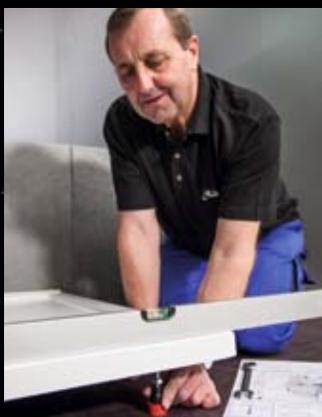
**9** Das waagrechte Ausrichten erfolgt durch Drehen des Kunststoff-Teils an den Wannenträgern. Anschließend alle Kunststoff-Füße mit Kontermuttern sichern.
