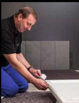
**6** Mauerseitige Wannenträger mit Schalldämmband bekleben.
